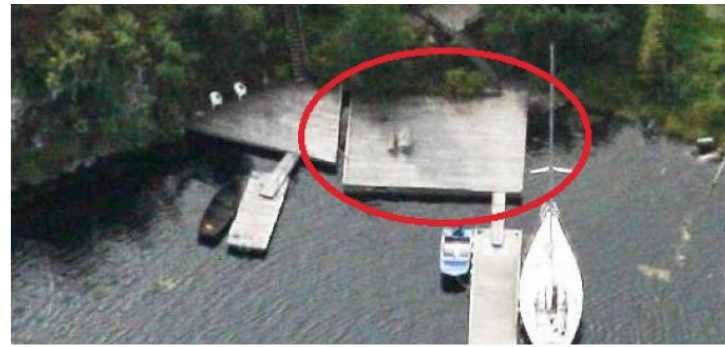
Byggen ble oppført på 70-tallet, og er ett av svært mange strandsonetiltak norske kommuner ønsker tilbakeført. (Foto: Arkiv)
